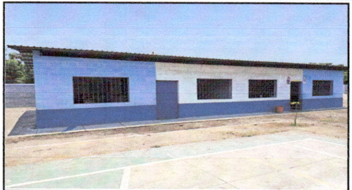
Foto 2: pintura interior y exterior de las aulas
