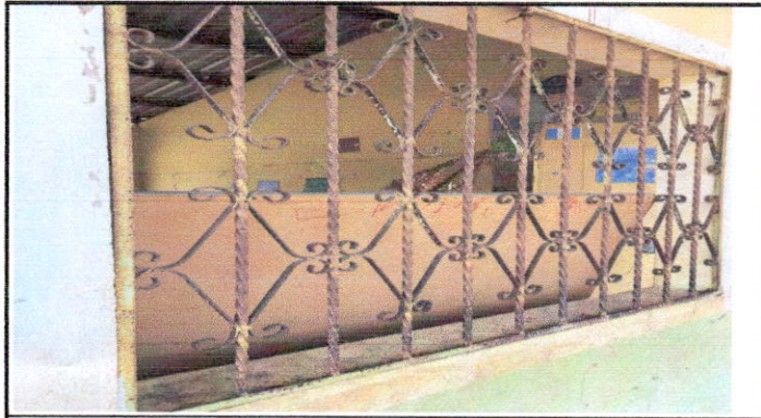
Foto 1: sustitucion de balcones
