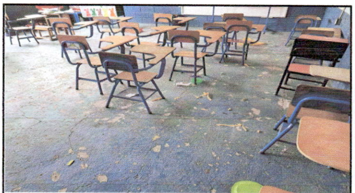
Foto 4: sustitucion de torta de cemento por piso cerámico
